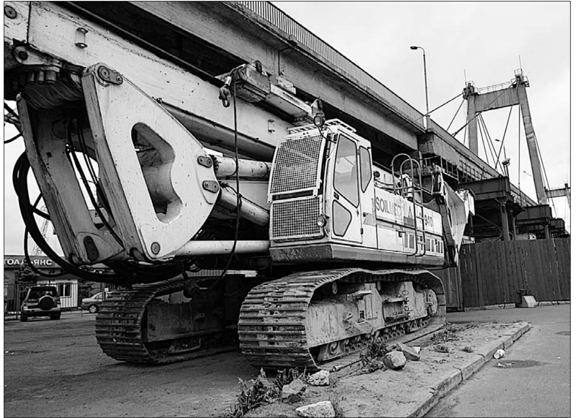
День работы этой итальянской буровой установки обходится «Мостобуду» более 20 тыс. грн.
